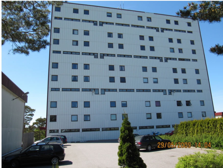
Gullveien borettslag pr. 2010, høyblokk. Foto: Boligbyggelaget.
