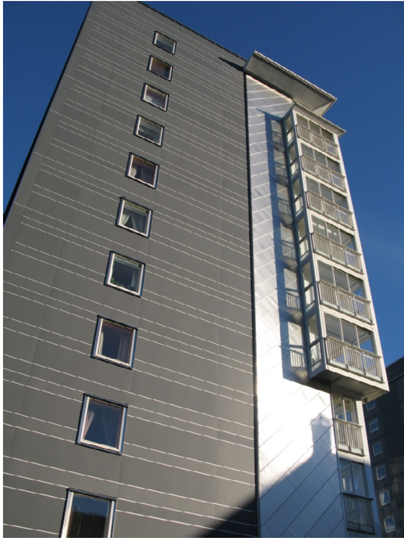
De nye gavlveggene, høsten 2010. Foto: SINTEF Byggforsk
