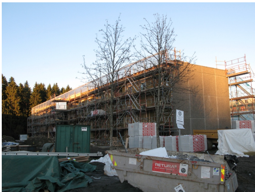
Myhrerenga borettslag under oppgradering. Foto: SINTEF Byggforsk.
