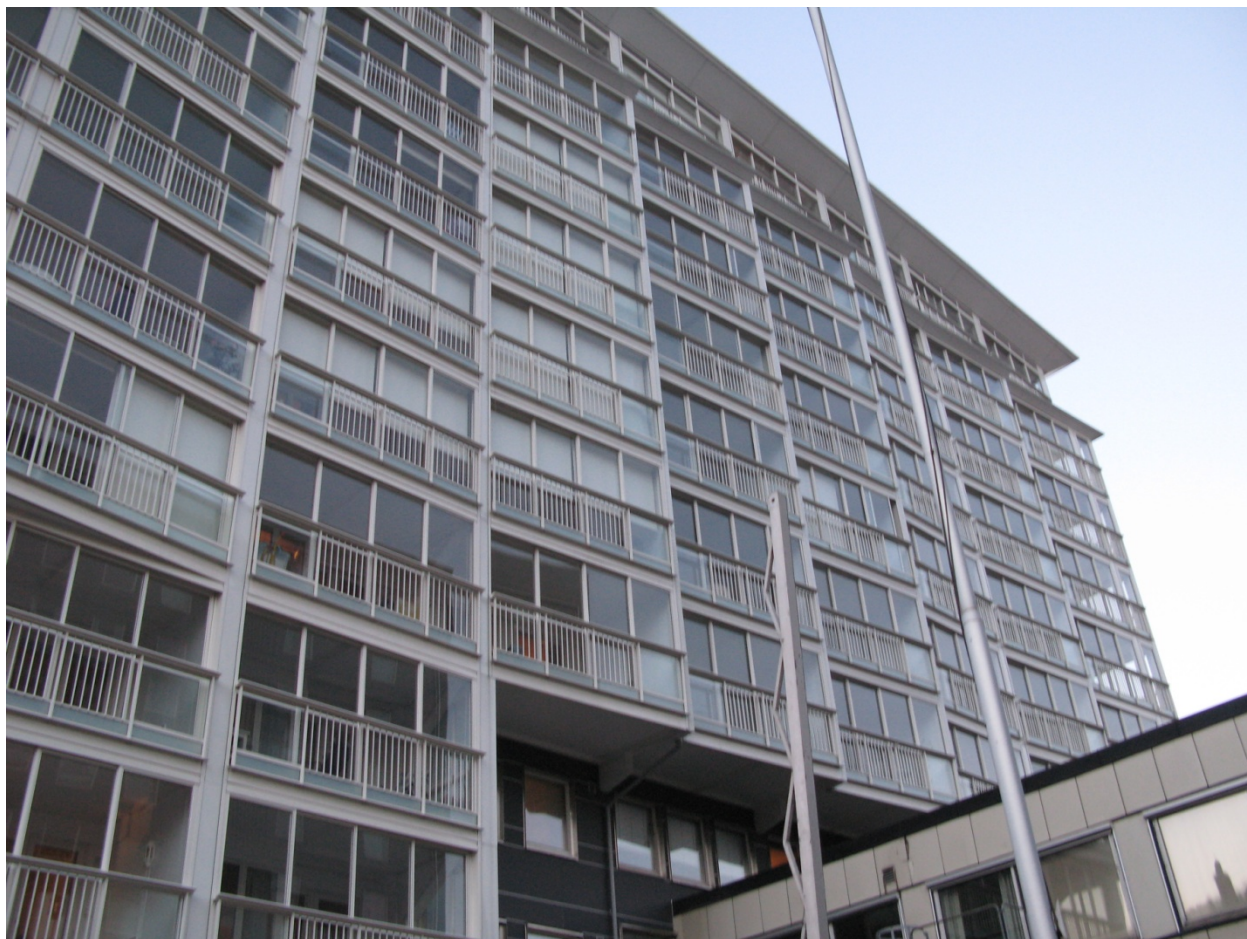
Nye innglassede fasader. Foto: SINTEF Byggforsk.
